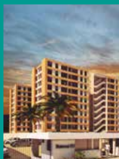
CONDOMINIO PARINAS III (2015).
