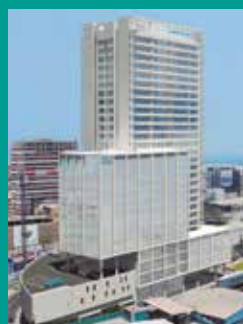
TORRE CAPITAL (EN CONSTRUCCIÓN).
